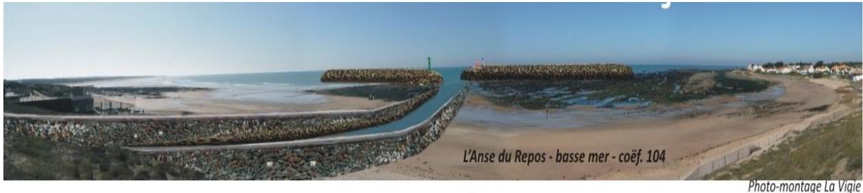
Comme toute barrière anti-houle placée au large, les récifs artificiels modifieraient les courants locaux et provoqueraient la formation de tombolos avec ensablement naturel de l'estran côté plage. Le chenal et ses murs de protection bloqueraient le transit sédimentaire nord/sud et aggraveraient l'ensablement naturel du nord du chenal.
